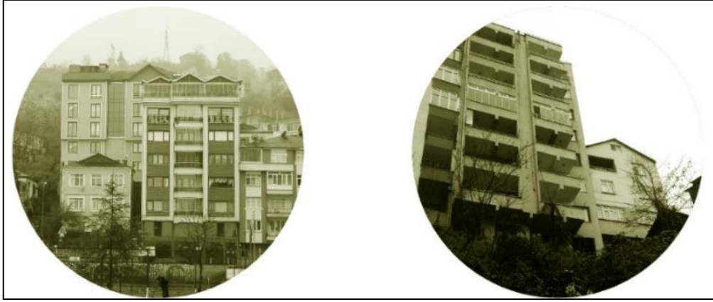
Şekil 55. Geleneksel yapı apartman ilişkisi
